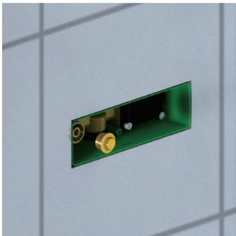
Нанесите водонепроницаемый герметик в месте соединения облицовки с монтажной коробкой.
